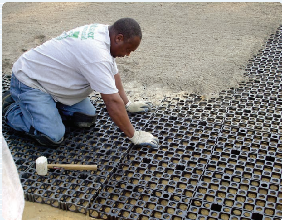
Gravel Cell® förstärkning och uppbyggnad används här för infartsvägarna och parkeringsplatserna.
