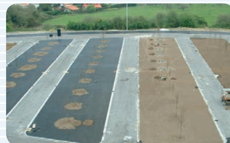
Gravel Cell® förstärkning och uppbyggnad används här för infartsvägarna och parkeringsplatserna.
