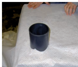
Skär ett X i geotextilen och trä den över genomföringen. X:et ska vara något mindre än genomföringen för att den ska sitta åt ordentligt.
