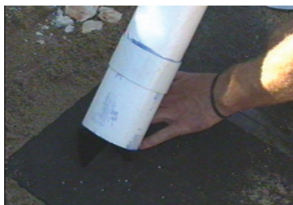
För in anslutningsröret genom geotextilen.
