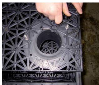
Klipp, såga eller skär ut ett hål i kassetten motsvarande genomföringen du ska göra. Skruva fast genomföringen i kassetten.
