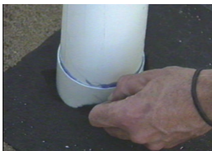
Tryck ner anslutningen genom geotextilen och vidare ner i kassetten.
