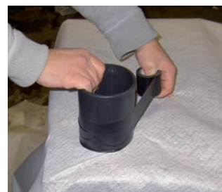
Fäst geotextilens flikar med en rostfri slangklämma eller tejsa fast dem hårt. Använd en stark tejp.
