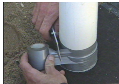
Geotextilens flikar ska fästas med en rostfri slangklämma eller tejsa fast flikarna med en stark tejp.
