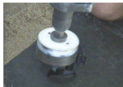
Borra, skär eller klipp upp ett hål, stort nog för att få ner anslutningsröret i kassetten.
